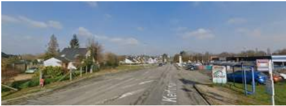
rue Georges Cadoudal au niveau de la sortie de la RN165
