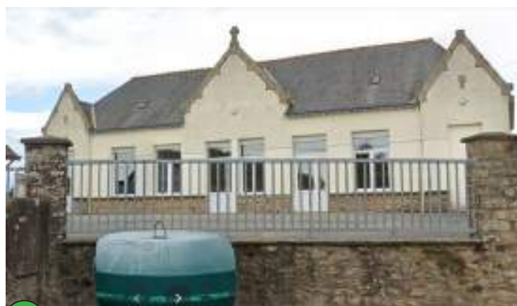
15 Salle Nicolazic (projet de réhab en cours)
