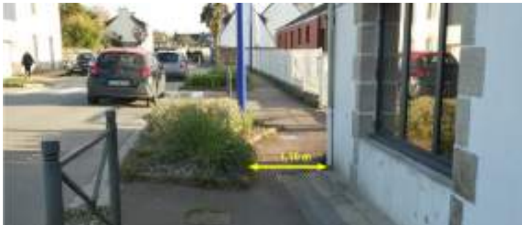
Accès à l'école publique (portail B) par la rue de la Gare : un trottoir non conforme, encombré par un massif de végétaux.
